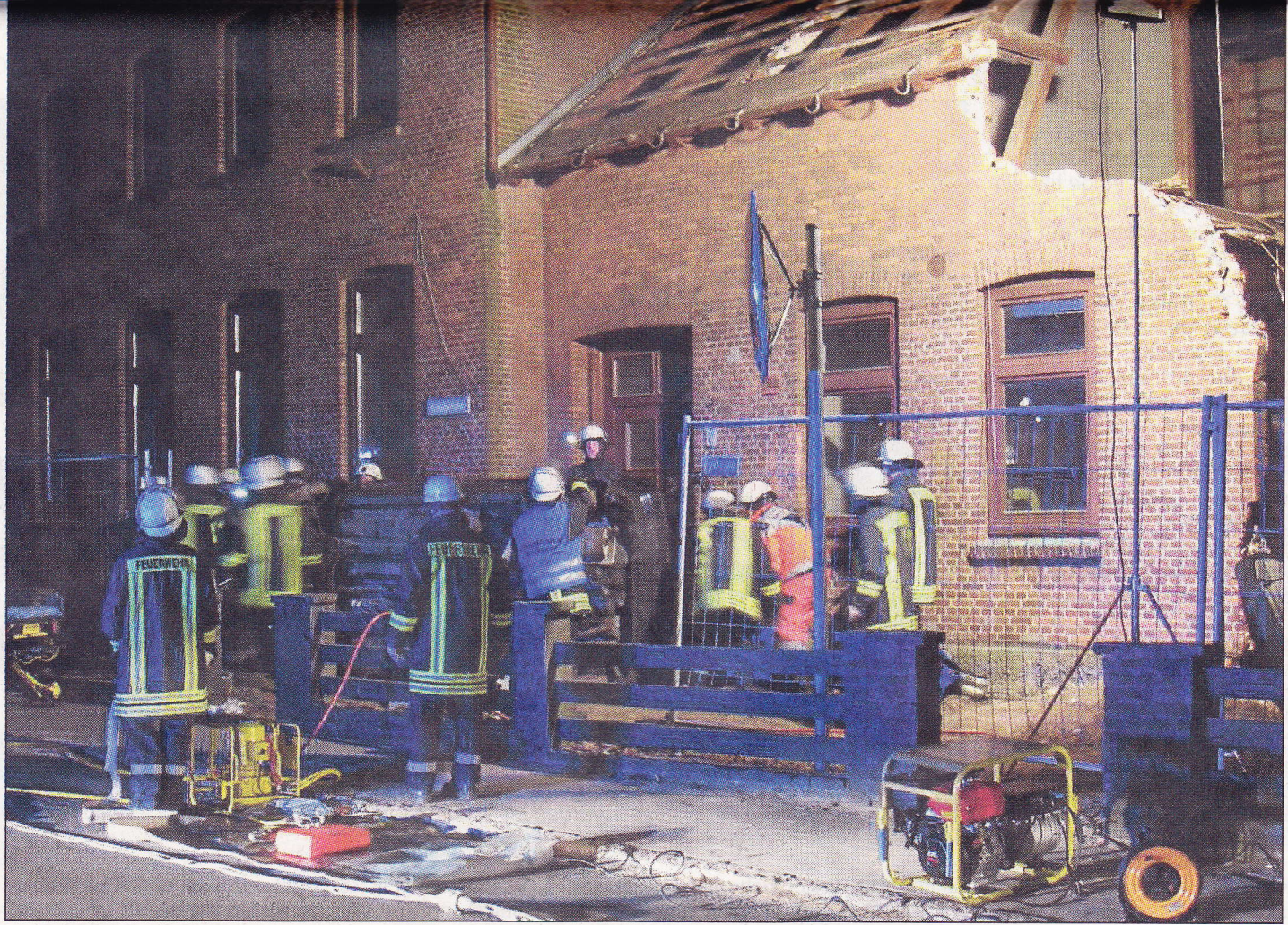
Gut verlaufen: Das alte Kindergartengebäude diente 130 Feuerwehrmännern als Übungsort. Nach Ostern ziehen die kleinen Süderhastedter in die neue Einrichtung. Fotos: Haß/Rohwedder
